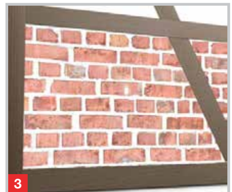
Neuverfugen mit Fugenmörtel ZF
