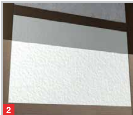
Einbringen von Fachwerkmörtel
