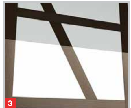
Grundieren mit Silikatfestiger und Beschichten mit Historic Kalkfarbe
